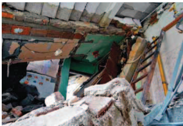
Schodišťový prostor mezi 3. NP a 4. NP, 15. září 2013
