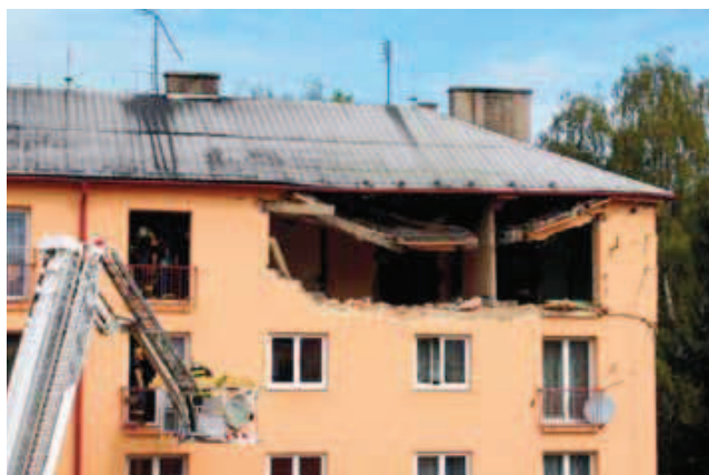
Stropní konstrukce nad 4. NP, 15. září 2013
