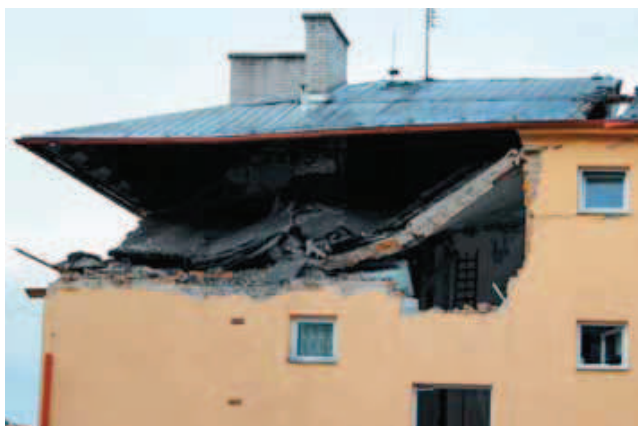
Stropní konstrukce nad 4. NP ze strany vchodu, 16. září 2013
