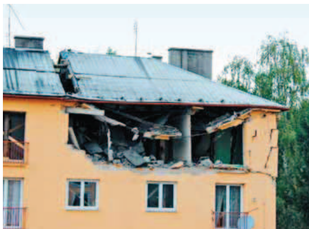
Stropní konstrukce nad 4. NP, 16. září 2013
