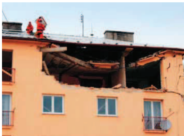
Oddělování střešní konstrukce nad poškozeným objektem, 15. září 2013
