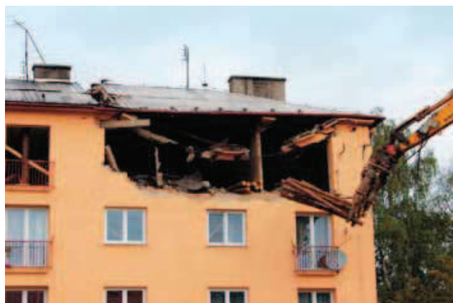
Umísťování kulatiny do prostoru 4. NP, 16. září 2013
