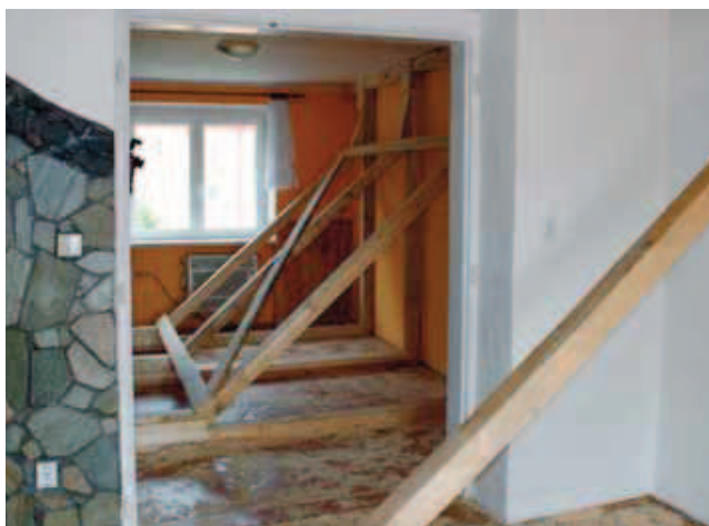
Výdřevy v bytě ve 4. NP sousedního objektu, 16. září 2013
