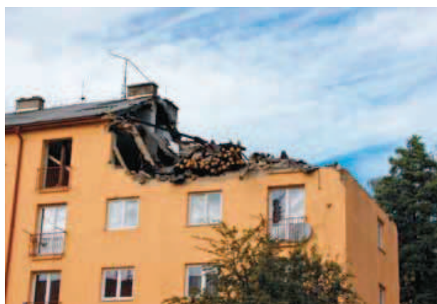
Ukončení hrubých bourací prací, 16. září 2013
