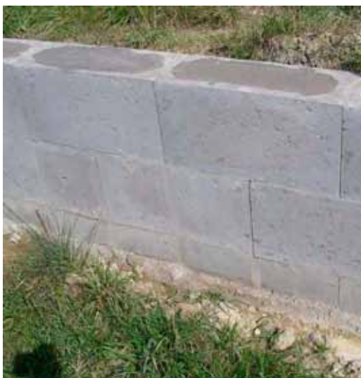
Podezdívka plotu z tvarovek ztraceného bednění
