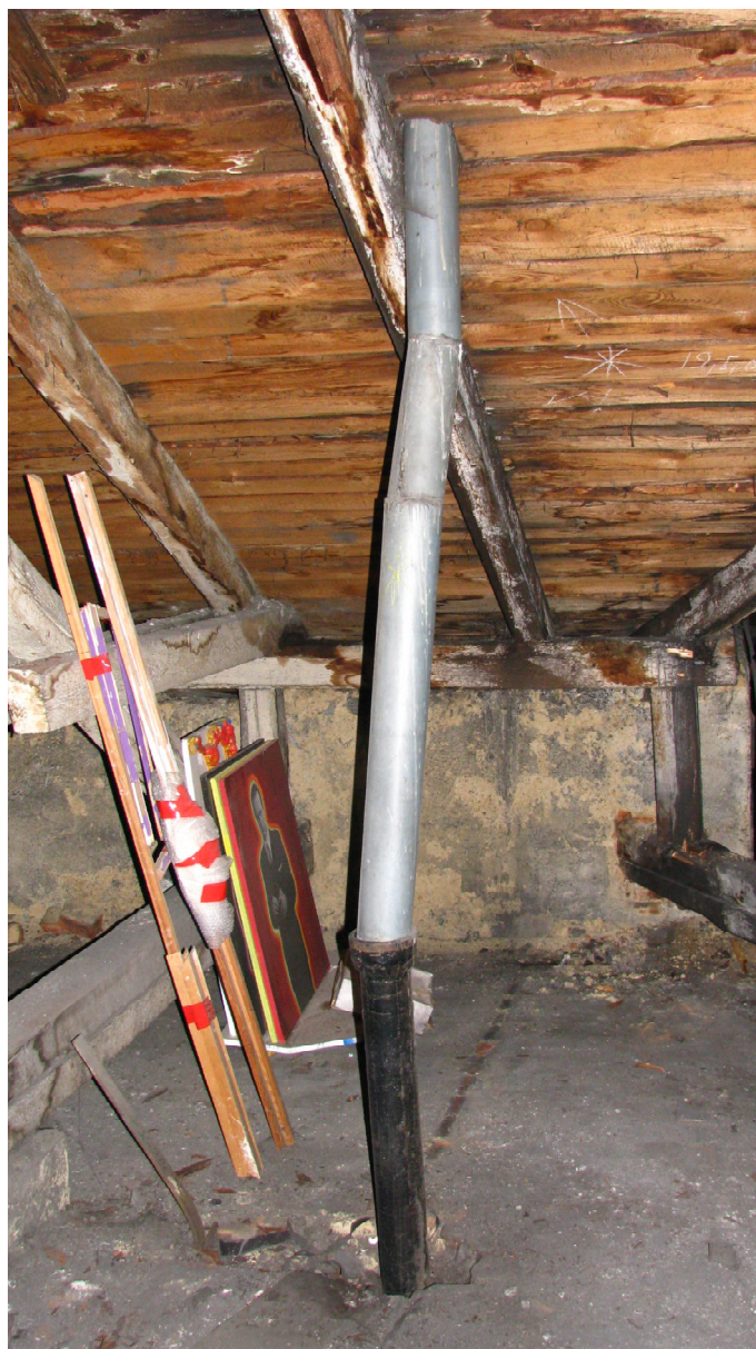
Stávající střešní konstrukce a stav půdního prostoru (ilustrativní fotografie)
